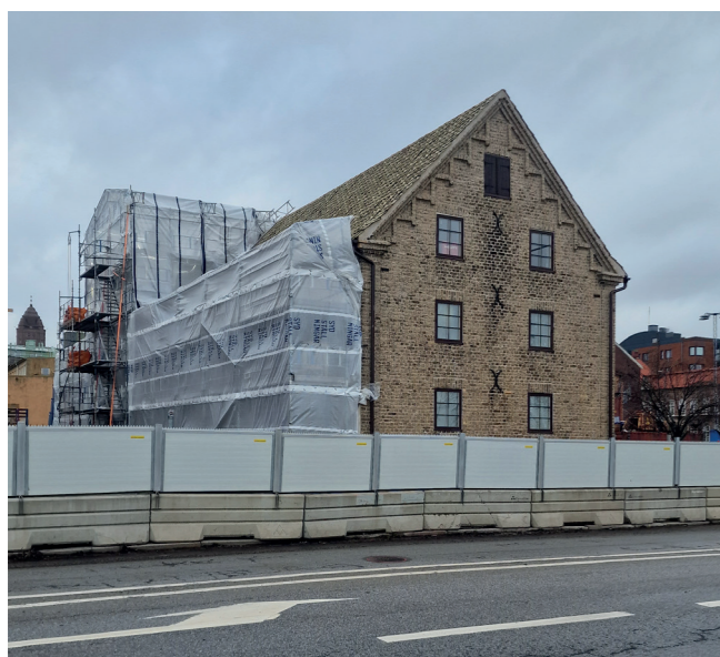
UNIK Byggtreprenad Sverige AB totalrenoverar Thelinska magasinet i Trelleborg och integrerar det med det nya Willow Hotel.
