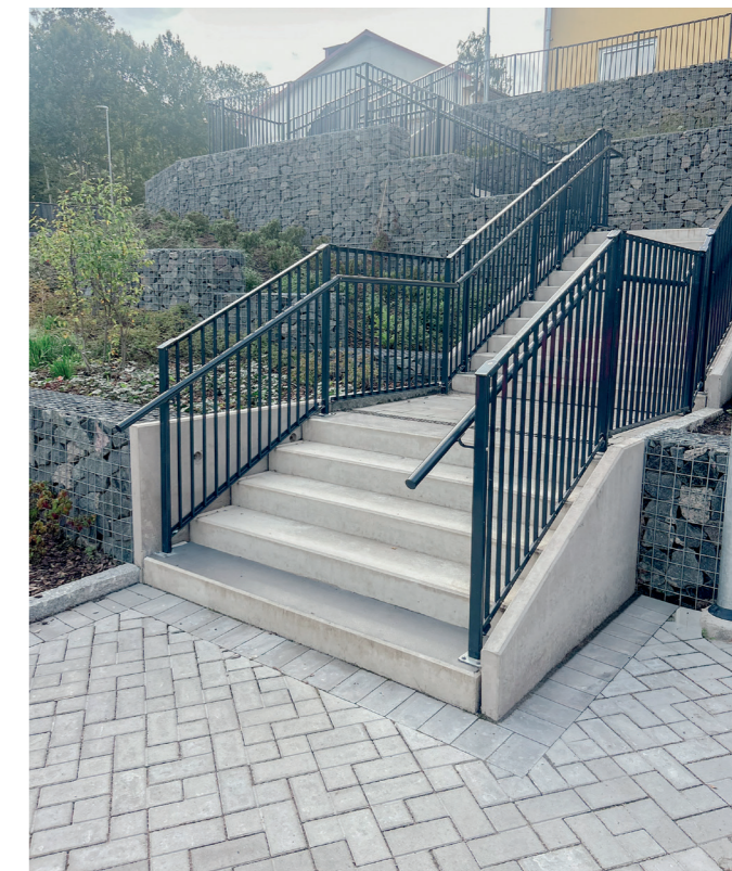
I utemiljön vid en tillbyggnad av en skola sker plattläggning, trappbygge, anläggning av gabionmurar och planteringar.
