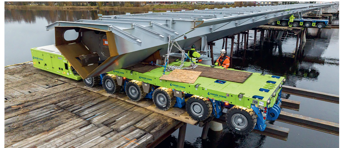
Det spektakulära lyftet av bron vid Lofbergs Arena.
