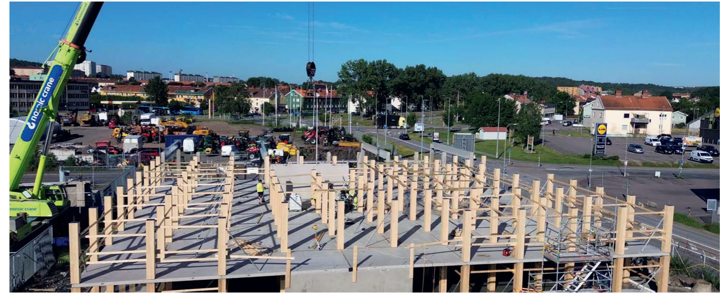
Betongelement lyfts upp på bygget.
