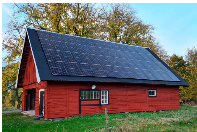
En av alla våra installationer på lantbruk.
