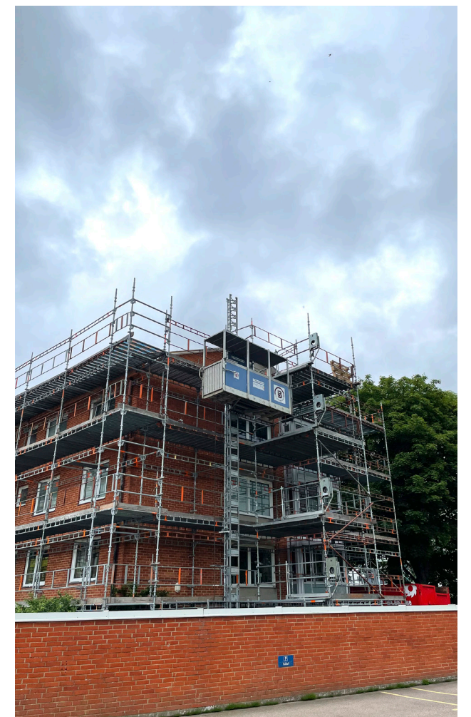
Byggställning från Lyft & Byggmaskiner och bygghiss från Lyft & Byggkranar AB
