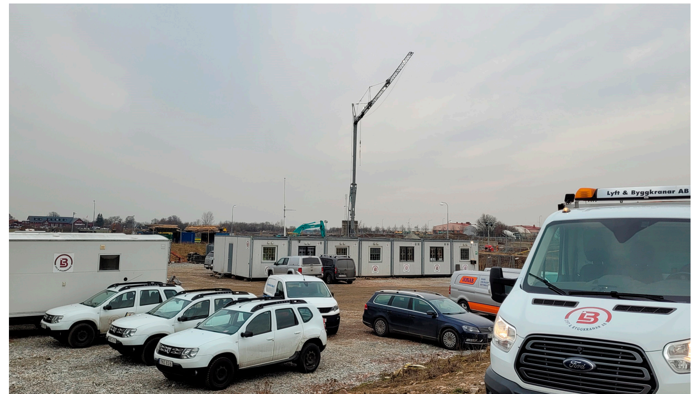
Arbetsbodarna från Lyft & Byggmaskiner och kran från Lyft & Byggkranar AB
