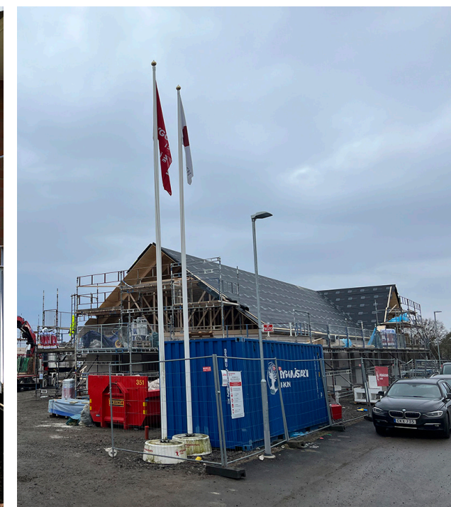
Nu byggs 1200 m2 förskola. Klart sommaren -23.
